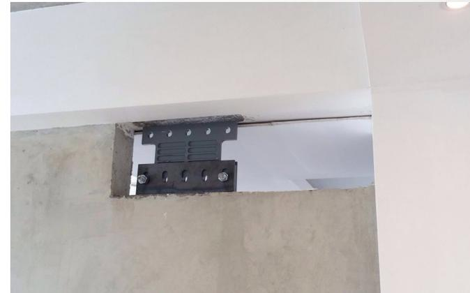
Muros acoplados con Marco mediante Disipador de energía sísmica facilitando discontinuidad del muro
