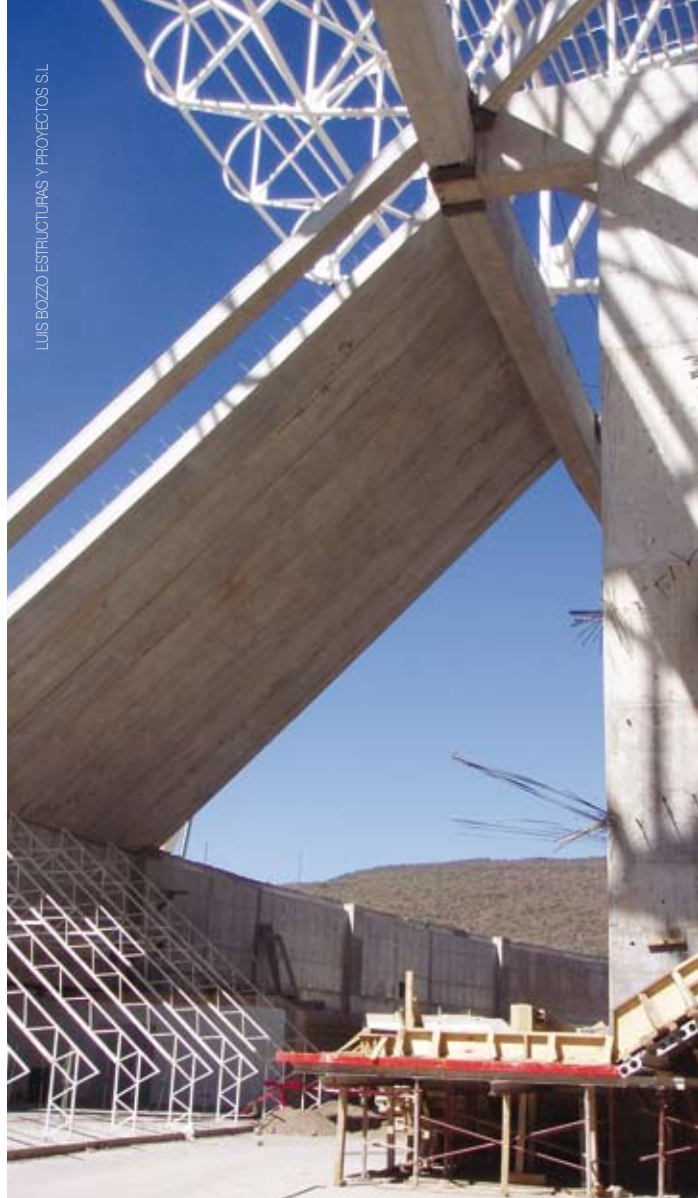
Berma hueca del estadio
