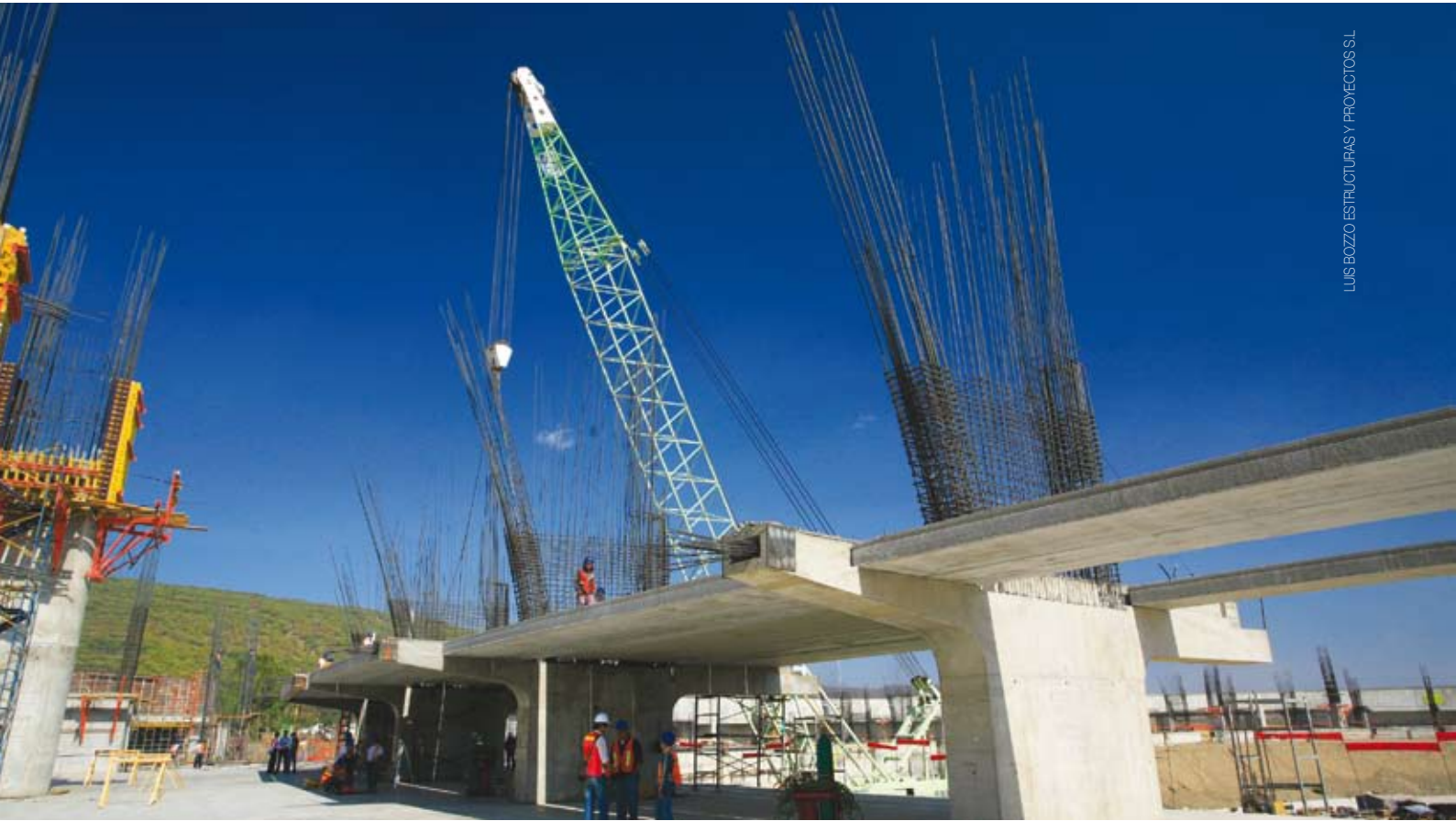
Elementos portagradas postensados
