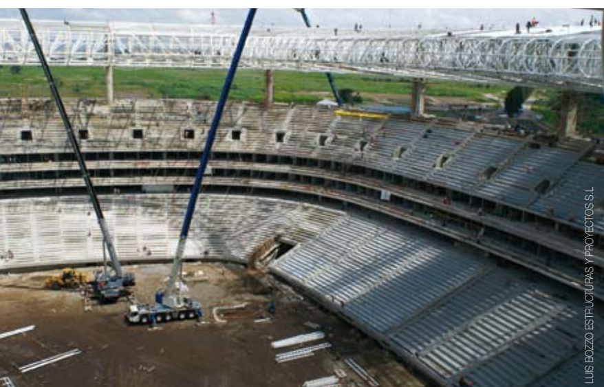
Vista interior de la construcción de la estructura del estadio
