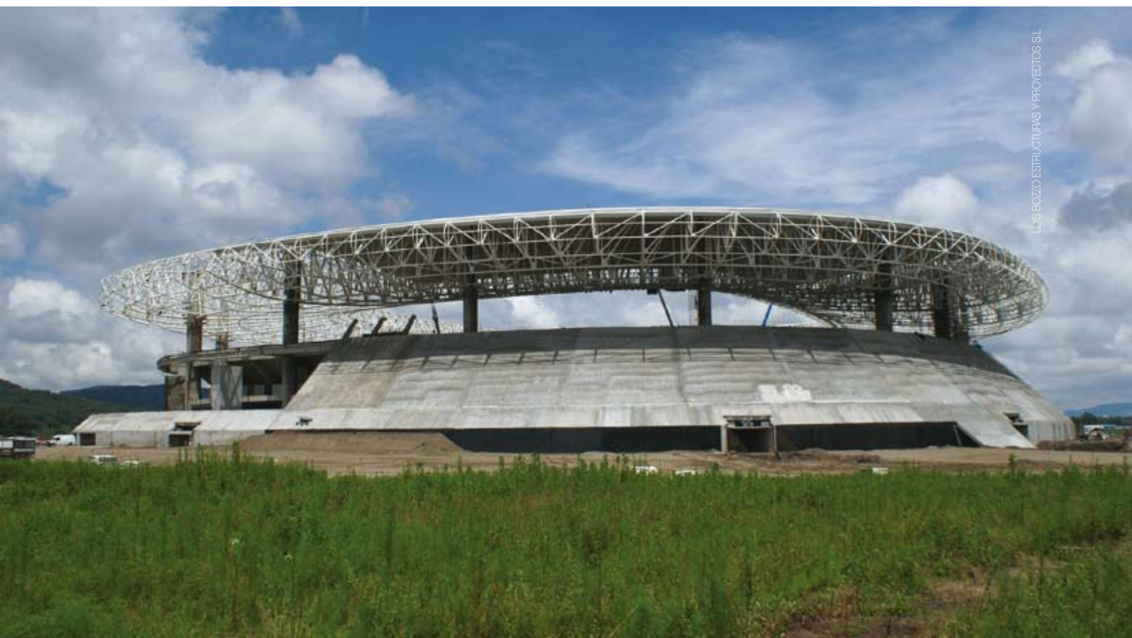
Vista exterior de la construcción de la estructura del estadi
